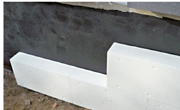
Abbildung 68 Angebrachte Perimeterdämmung im Sockelbereich
