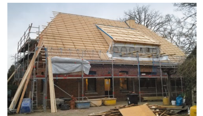
Abbildung 39 Aufsparrendämmung
