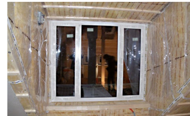
Abbildung 43 Dachgaube mit umlaufend angeschlossener Dampfbremse
