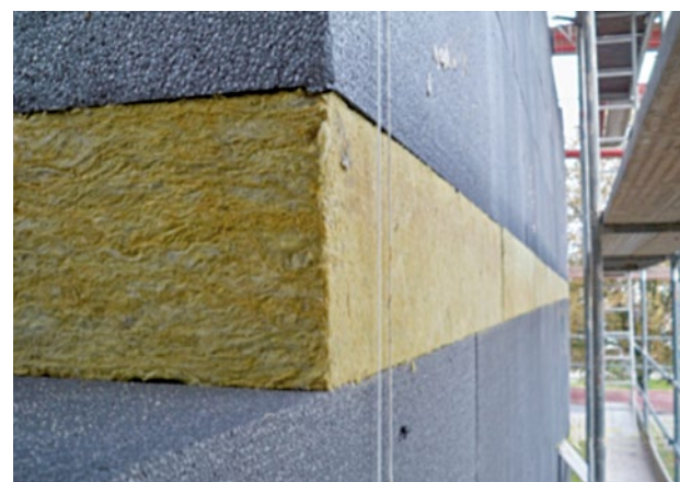
Abbildung 22 Brandriegel aus Mineralwolle
