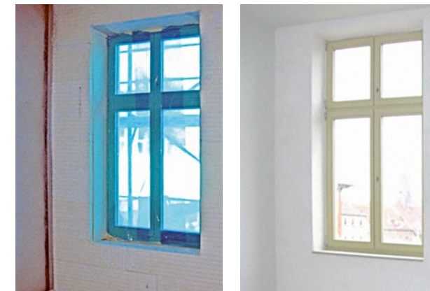
Abbildung 81/82 Einsatz eines Innenwand-Dämmsystems unter Einbeziehung der Fensterlaibungen
