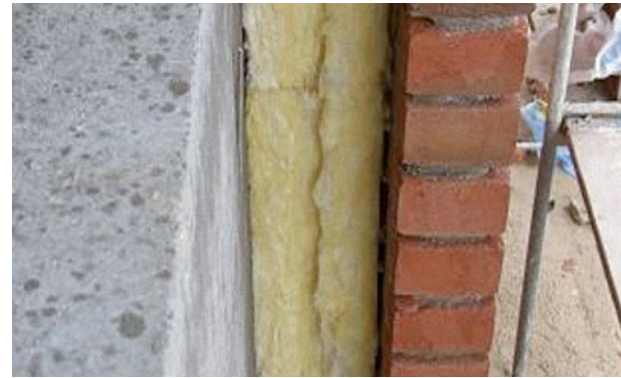
Abbildung 76 Einbau einer Kerndämmung (Neubau)
