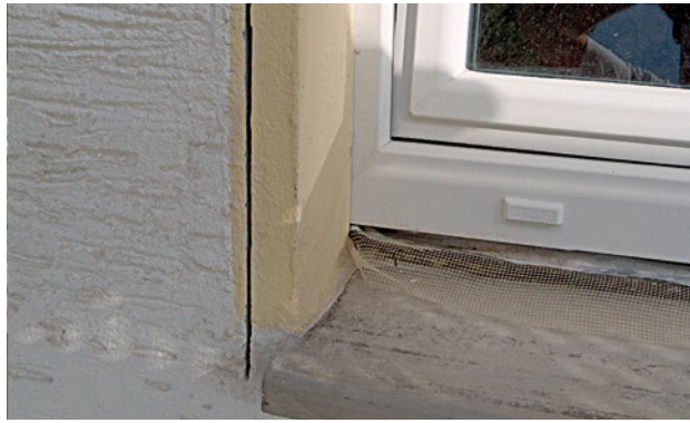
Abbildung 87 Massiver Mauerwerksanschlag wird eingeschnitten und abgebrochen
