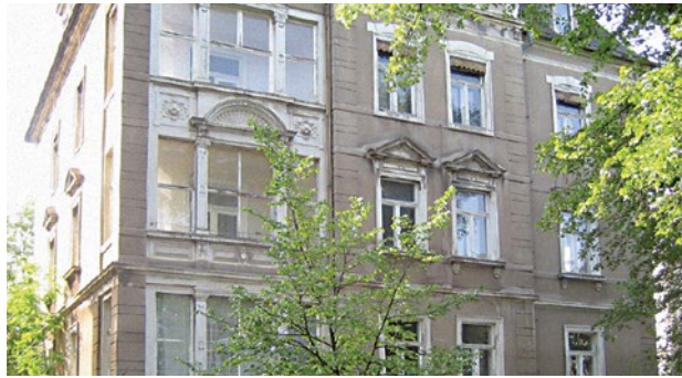
Abbildung 84 Typische Kastenfenster und einfache Wintergartenverglasung um 1900
