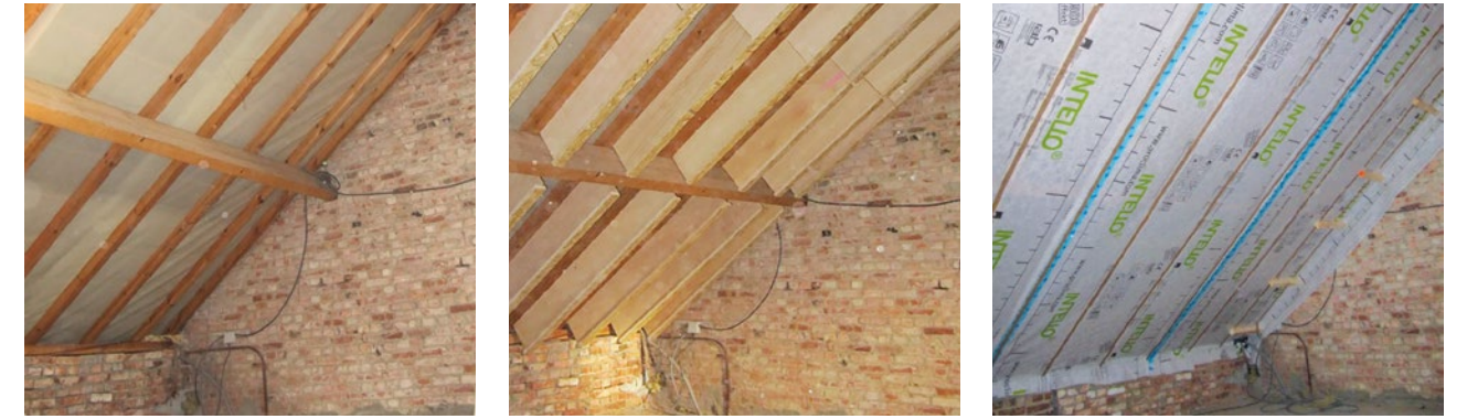
Abbildung 35 - 37 Vergrößerung des Sparrenzwischenraums durch seitlich angebrachte Sparrenexpander aus Holz
