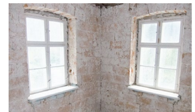
Abbildung 83 Fenster im Bestand mit Einfachverglasung
