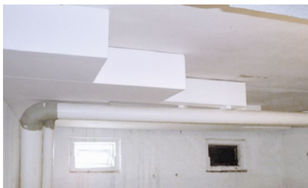
Abbildung 95 Verkleidung der Decke mit 20 cm starken Dämmplatten
