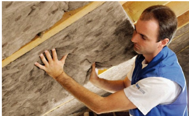
Abbildung 33 Einbau einer Mineralwolldämmung zwischen den Sparren
