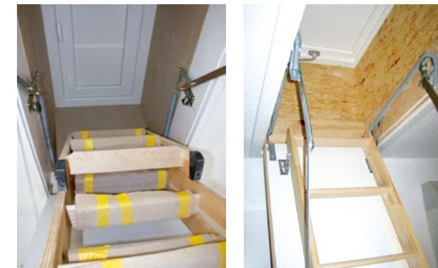
Abbildung 57/58 Neueingebaute Bodentreppen mit zusätzlich gedämmter Bodenklappe
