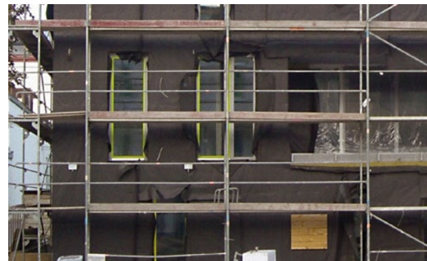
Abbildung 73 Anbringen der diffusionsoffenen Unterspannbahn
