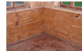
Abbildung 18 Rauminnecke einer Außenwand aus Holz- Blockbohlen
