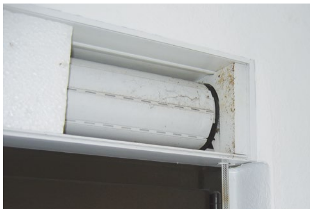
Abbildung 8 Rolladen ungedämmt
