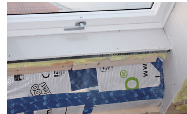
Abbildung 44 Anschluss Dampfbremse an Dachfenster
