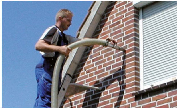
Abbildung 75 Einbringen einer Einblasdämmung (Bestand)
