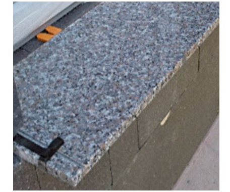
Abbildung 90/91 Fensterbank mit aufgeklebtem Quellband
