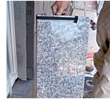
Abbildung 90/91 Fensterbank mit aufgeklebtem Quellband
