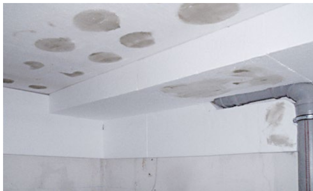
Abbildung 94 Kellerdecken- und Flankendämmung der Innenwand
