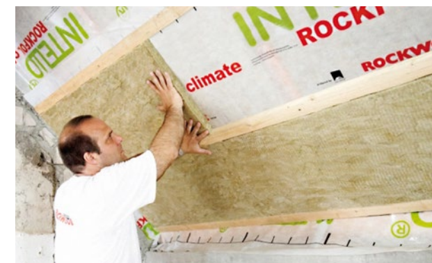
Abbildung 38 Einbau einer Untersparrendämmung zwischen die Konterlattung
