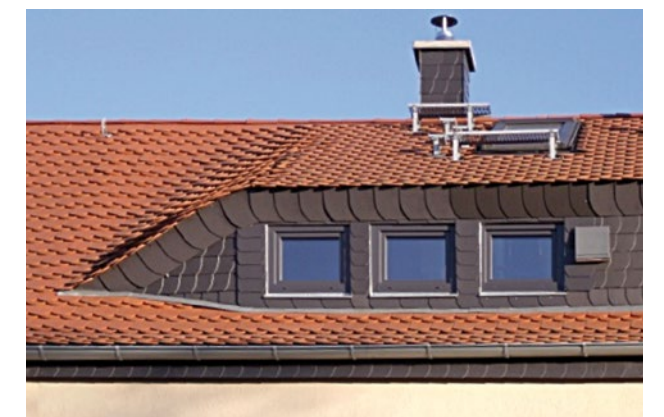
Abbildung 25 Saniertes Dach mit Dachgaube
