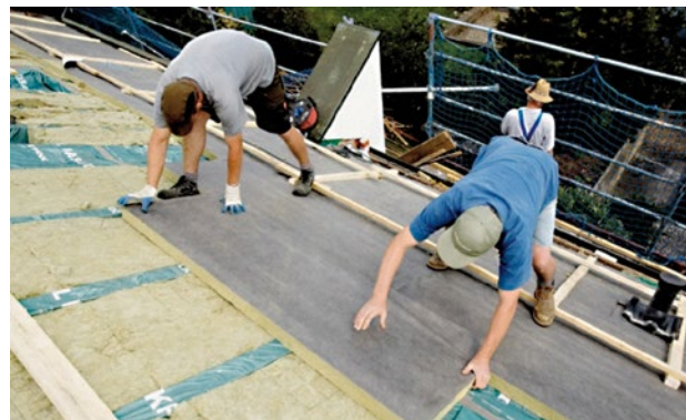
Abbildung 40/41 Nachträgliche Schrägdach-Dämmung in Kombination aus Auf- und Zwischensparrendämmung
