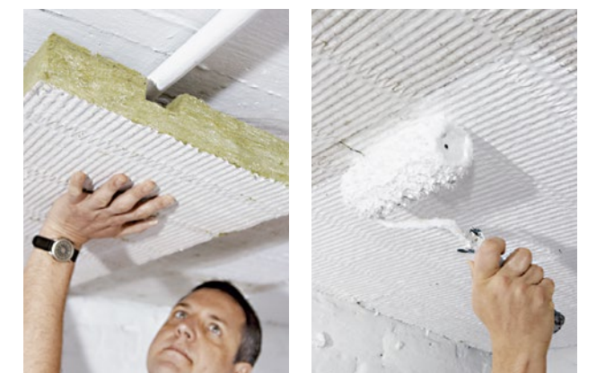
Abbildung 92/93 Anbringen einer mineralischen Unterdeckendämmung
