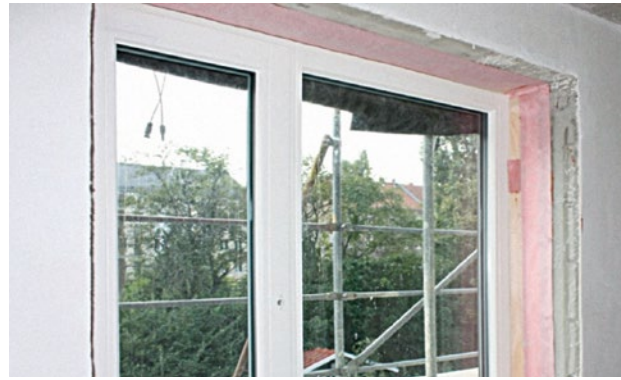
Abbildung 88 Einbau eines neuen Fensters mit Dichtklebeband
